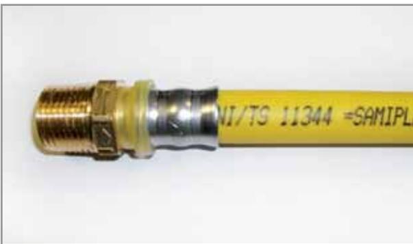
**6)** Eseguire la pressatura fino al contatto delle semi-ganasce.
