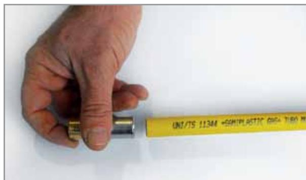
**4)** Inserire il raccordo nel tubo ruotandolo senza eccessivo sforzo facendolo arrivare a battuta. La ghiera in trasparenza mostra l'avvenuta battuta del tubo.
